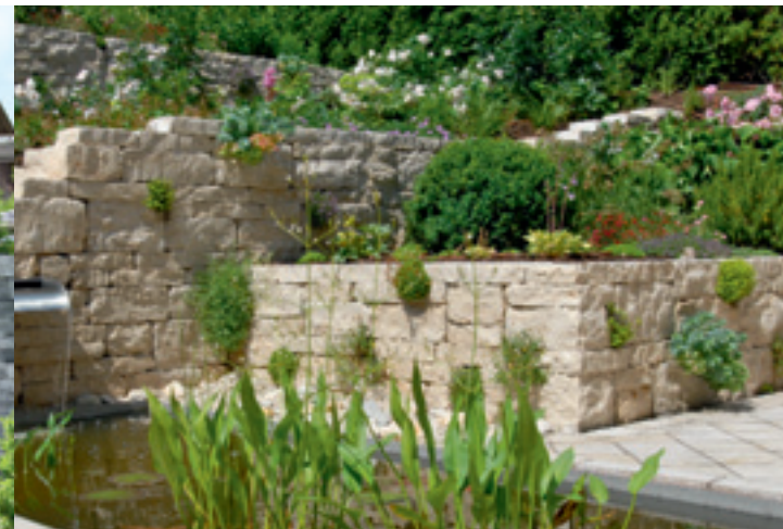
Natürlich: Trockenmauern aus Jurakalk-Bruchsteinen strukturieren das Hanggrundstück.
